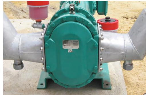
Bomba de alimentación para sustrato de biogás. Caudal hasta 40 m<sup>3</sup>/h bajo presión de 2 bar.
