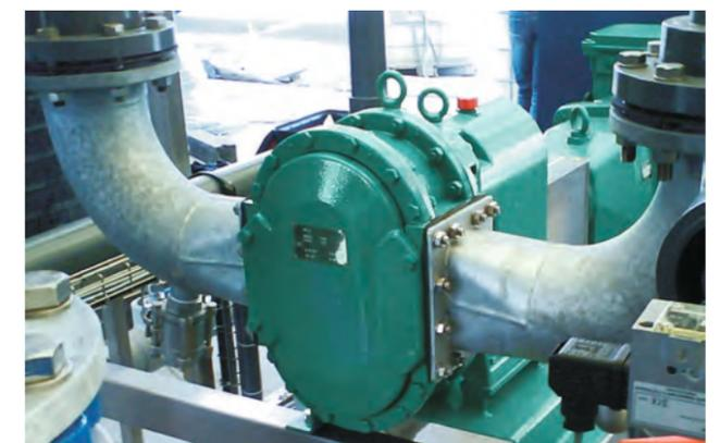
Una bomba TORNADO® para aguas residuales con 1-3% de sólidos en un sistema de filtro de membrana para caudal de hasta 80 m<sup>3</sup>/h en ambos los sentidos de rotación.
