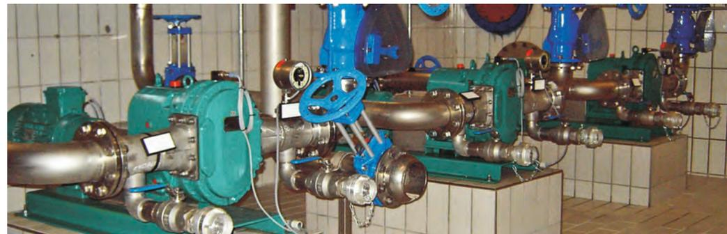
Aplicación en el tratamiento de aguas servidas y aguas residuales con 3% de TS, con caudal de 55 m<sup>3</sup>/h y presión de 2 bar.
