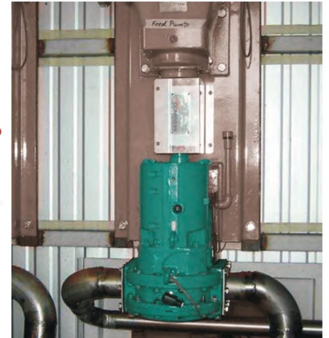
Una Bomba TORNADO® vertical en un container para alimentación de centrifuga con lodo de perforación de petróleo.
