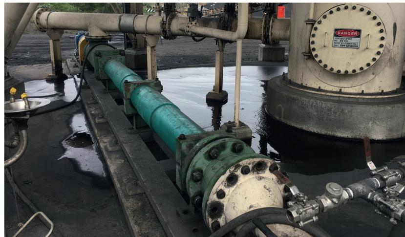
Excelentes para manejo de sólidos y capacidades de presión permiten el manejo de lodos complejos con las bombas de cavidad progresiva NEMO®.
