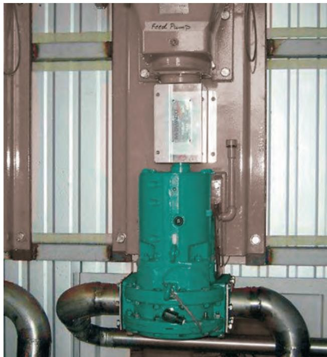
Bomba TORNADO® montada verticalmente em um container para alimentação de centrífuga com lodo de perfuração de petróleo.
