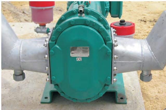
Bomba de alimentação para um substrato de biogás.
