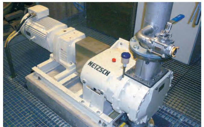
Bomba TORNADO® em uma fábrica de papel para descarregar caulim de navios tanque. A vazão é de 75 m<sup>3</sup>/h e pressão de 4 bar.
